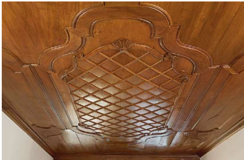
Decke im zweiten Obergeschoss nach der Freilegung, Restaurierung und Neubehandlung mit Schelllack: eine der reichsten Rokoko-Decken im Kanton.
