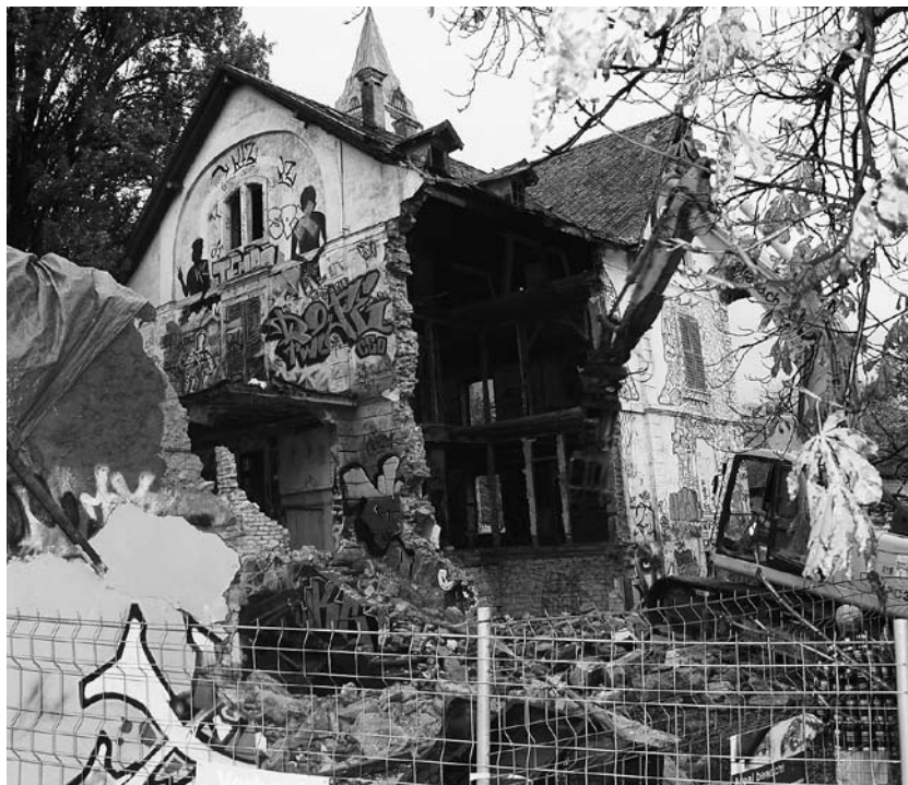
Démolition de l'ancienne Villa Ritter.
